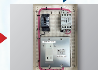
操作盤の取付
