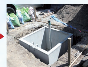
融雪槽本体埋設
